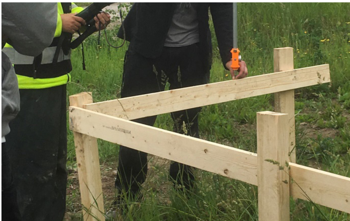
Exempel på husutsättning där husets grund markeras i varje hörn eller vinkel.
